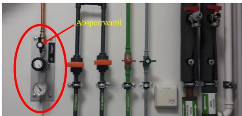
Abbildung 5.1: Position der Argonleitung. Absperrventil in senkrechter Position, Leitung offen (wie in der Abbildung zu sehen). Absperrventil in waagerechter Position, Leitung zu.
