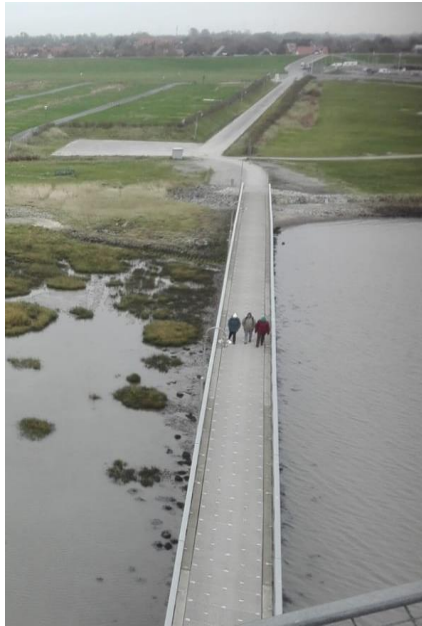
Abb. 11: Probenahmestelle beim Leuchtturmdenkmal Obversand. Die Proben wurden auf der rechten Seite des Stegs entnommen.
