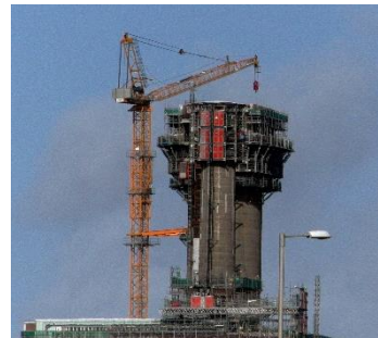
Abb. 5: Rückbau des Schornsteins von Reaktor Pile-1 in Sellafield (2019).
